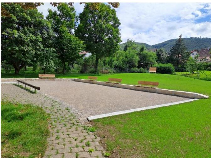
Alles in allem haben wir 125 Tonnen Schotter, Split und Sand, 13 Tonnen Natursteine und 24m<sup>2</sup> Betonsteine verbaut und ca. 110 Tonnen Erdaushub bewegt.
